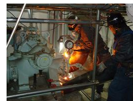
実機材解体検証
